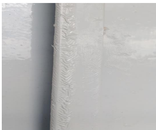
Figura 02 e 03 (respectivamente). Enrugamentos em esquadrias do Campus
