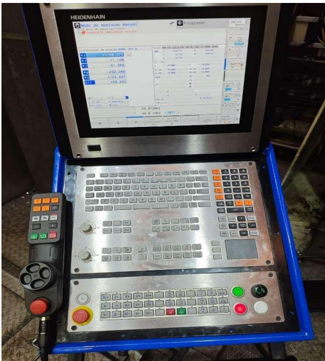
Figura 3: Vista do Pannel de Comando novo instalado na Mandriladora TOS.
