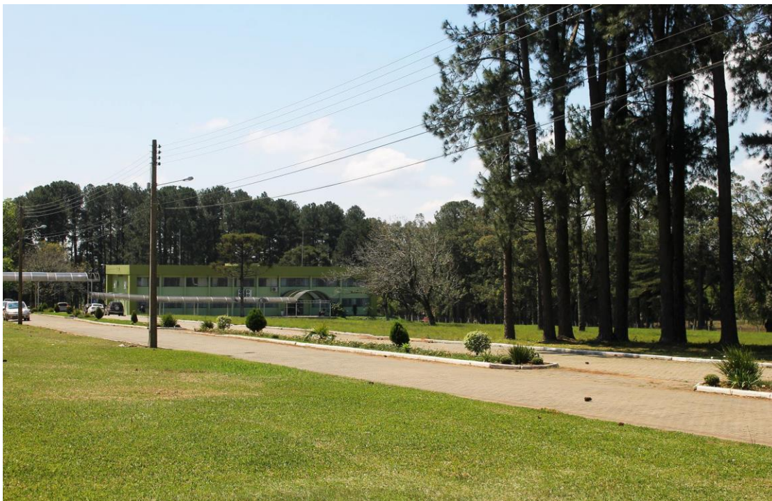
Figura 21: Vista da estrutura do Campus Jaguari (2016).
