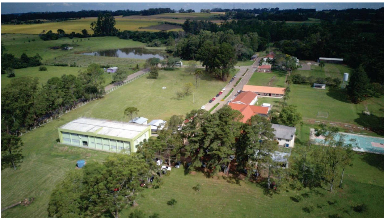
Figura 18: Vista do Campus Jaguari em fase inicial de estruturação (2014).
