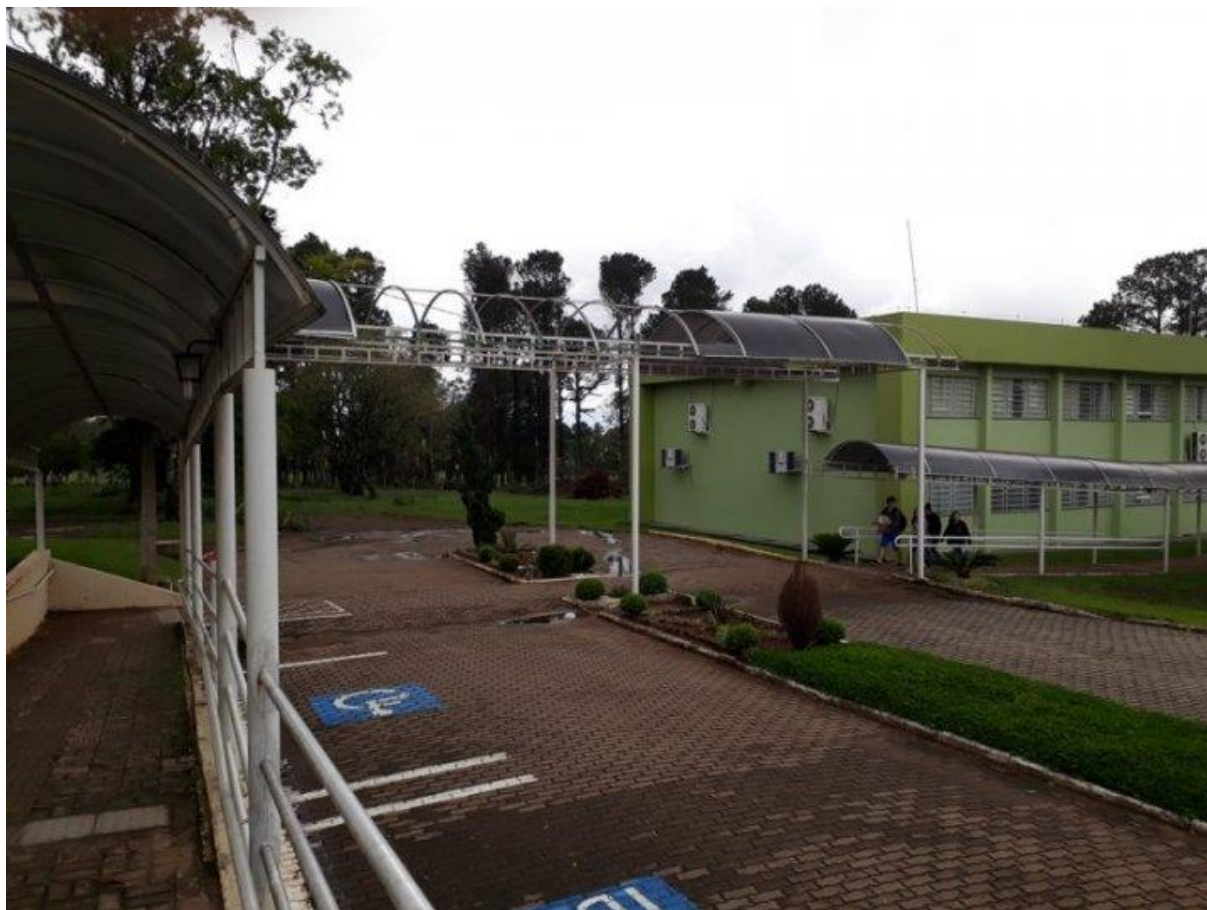
Figura 22: Danos estruturais provocados pelo temporal (2017).
