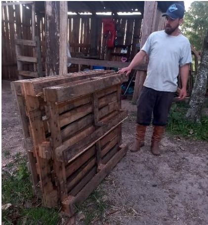
Figura 14. Construção da estrutura da horta vertical por Juliano. Fonte: (Autora, 2022)
