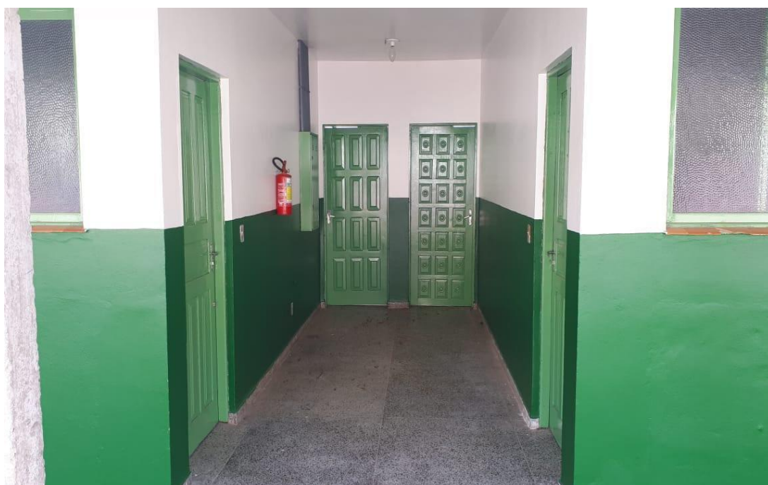
Fotografia 6 - Entrada de Apartamentos
