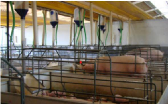
Figura 9: sala de maternidade com utilização de ducto fan para melhora de sensação térmica das fêmeas
