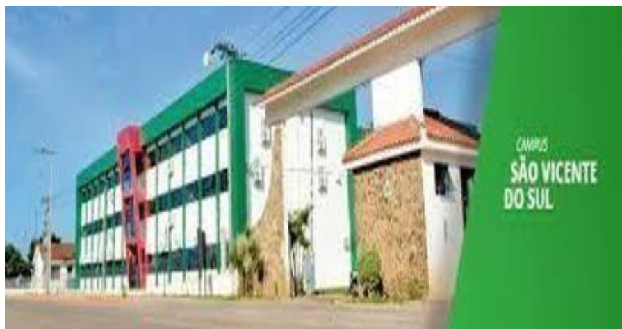
Figura 13: Prédio Campus IFFar – SVS atualmente
