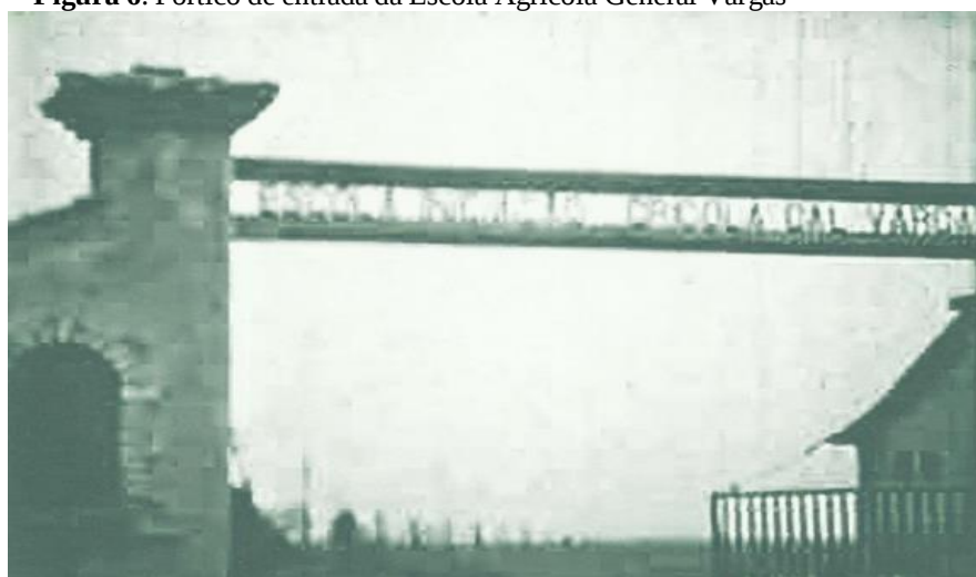
Figura 6: Pórtico de entrada da Escola Agrícola General Vargas
