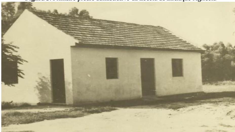
Figura 5: Primeiro prédio administrativo da Escola de Iniciação Agrícola
