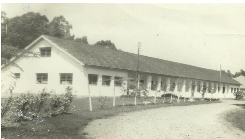
Figura 7: Ampliação do prédio administrativo da Escola Agrícola Federal em 1970
