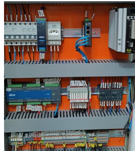
Figura 13 – Painel já montado.
