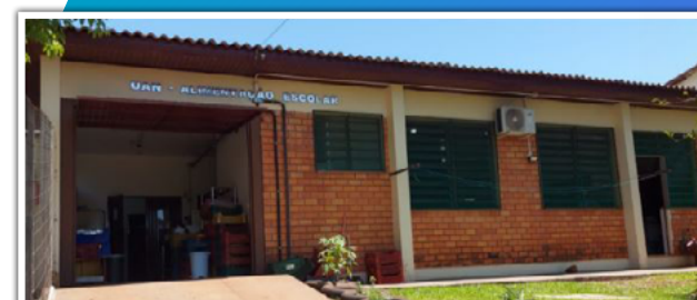
Fachada da Unidade
