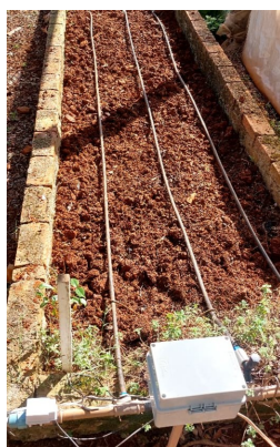
Figura 6. Canteiro com a infraestrutura instalada.
