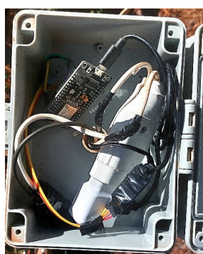
Figura 5. Instalação dos Componentes.
