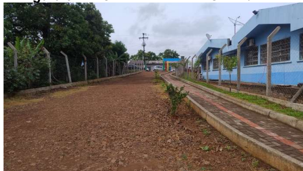
Figura 32 — Obras concluídas C. P. 1/24
