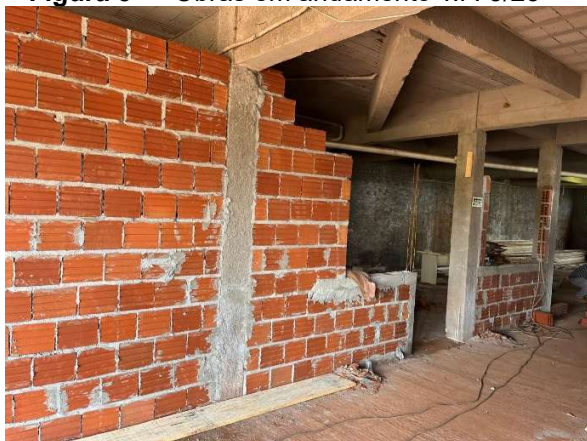
Figura 5 — Obras em andamento T.P. 3/23
