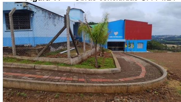
Figura 11 — Obras concluídas C. P. 1/24
