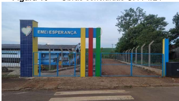
Figura 10 — Obras concluídas C. P. 1/24
