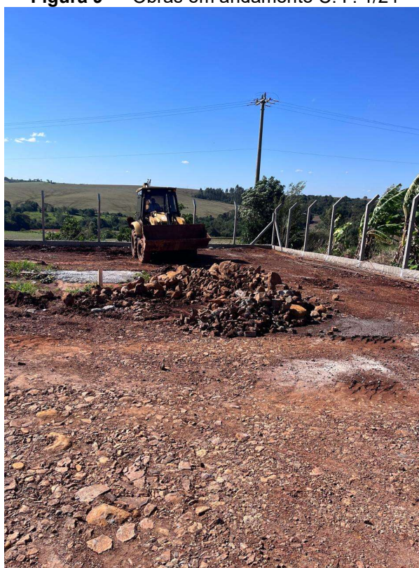
Figura 9 — Obras em andamento C. P. 1/24
