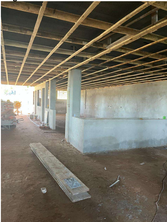
Figura 21 — Obras em andamento T.P. 3/23
