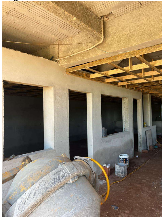
Figura 22 — Obras em andamento T.P. 3/23
