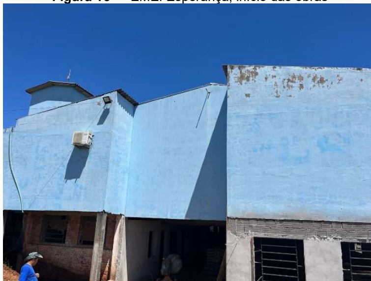
Figura 16 — EMEI Esperança, início das obras
