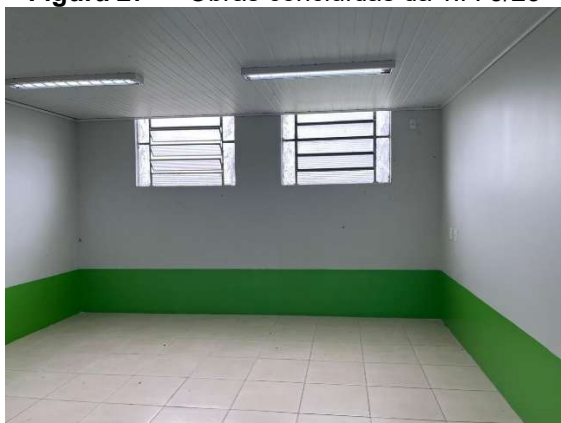
Figura 27 — Obras concluídas da T.P. 3/23
