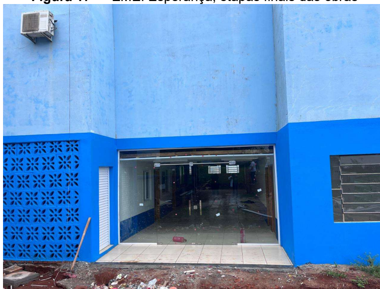
Figura 17 — EMEI Esperança, etapas finais das obras
