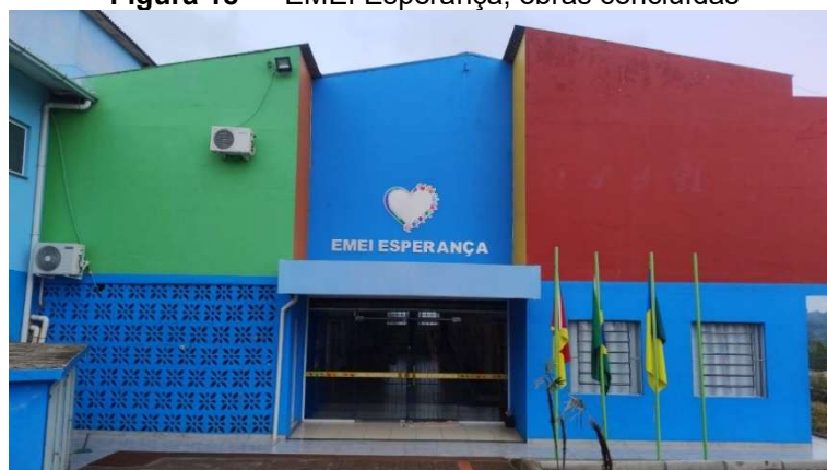
Figura 18 — EMEI Esperança, obras concluídas
