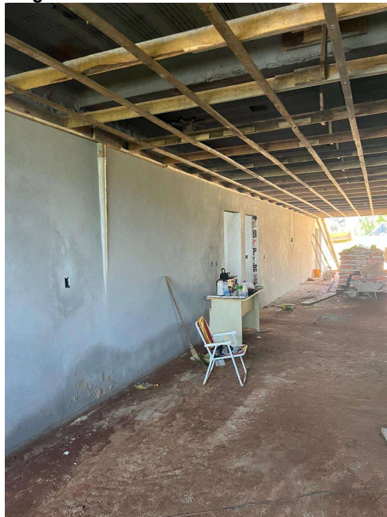
Figura 20 — Obras em andamento T.P. 3/23
