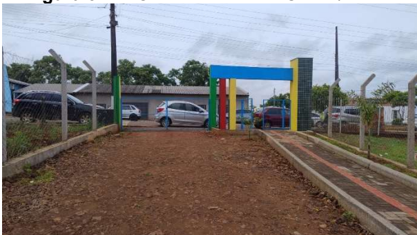
Figura 31 — Obras concluídas C. P. 1/24
