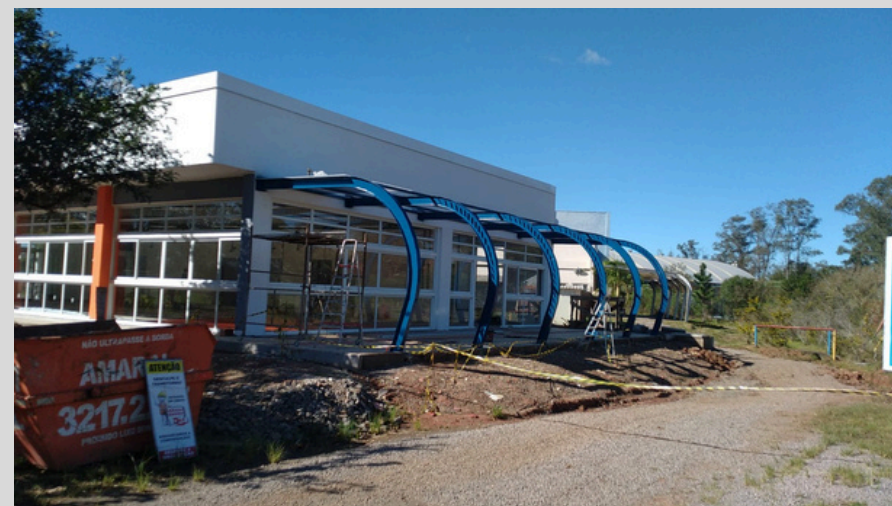
Figura 83 - Construção da Academia para os Alunos do Campus Fonte: Do Autor (2024)
