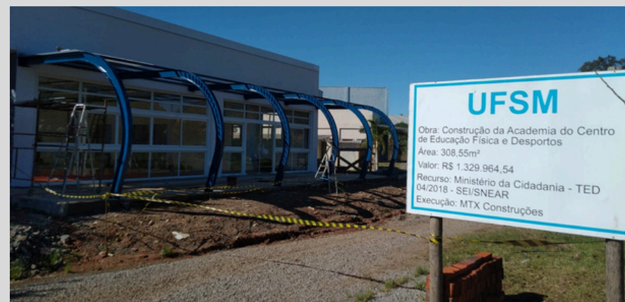
Figura 84 - Construção da Academia para os Alunos do Campus Fonte: Do Autor (2024)
