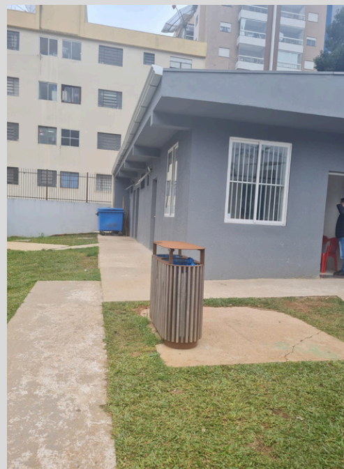
Figura 70 - Vestiários e Sala de Segurança Fonte: Do Autor (2024)
