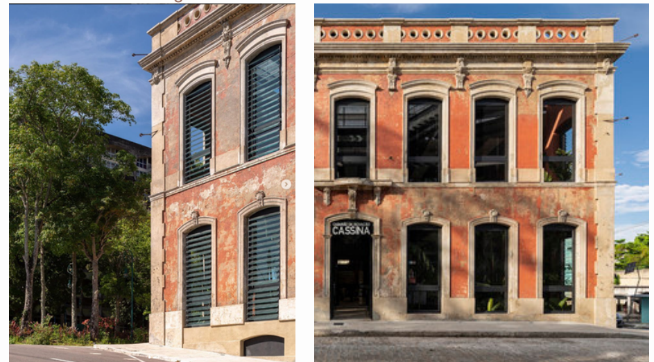
Figura 109: Elementos da fachada.
