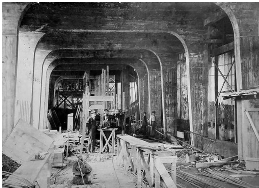
Figura 179: Recorte das alvenarias no retrofit.
