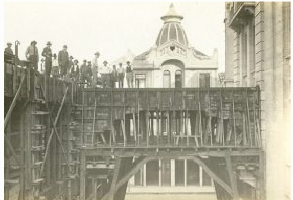
Figura 178: Construção da passarela.
