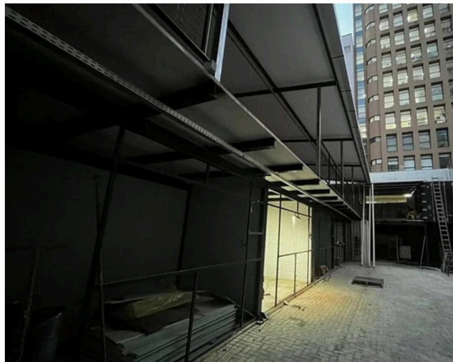
Figura 147: Estrutura metálica em processo de montagem.
