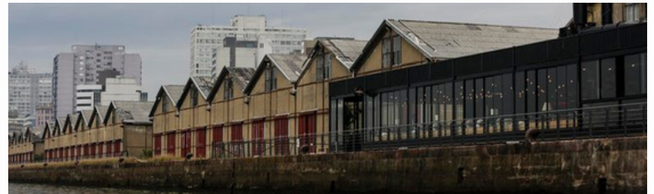
Figura 168: Conjunto fachada nova e da preexistência.
