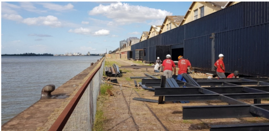
Figura 169: Instalação da estrutura dos restaurantes.
