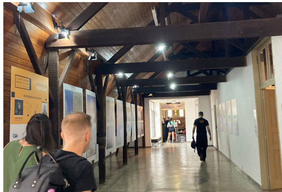
Figura 180: Estrutura do telhado aparente.
