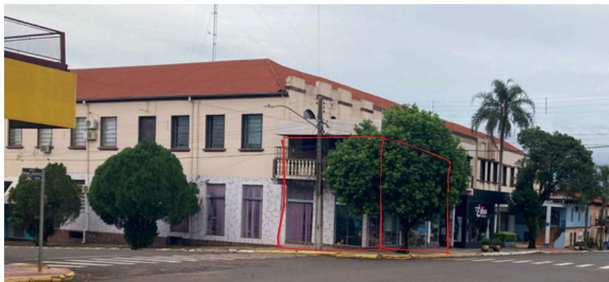
Figura 49: Demarcação da ampliação esquerda na fachada atual
