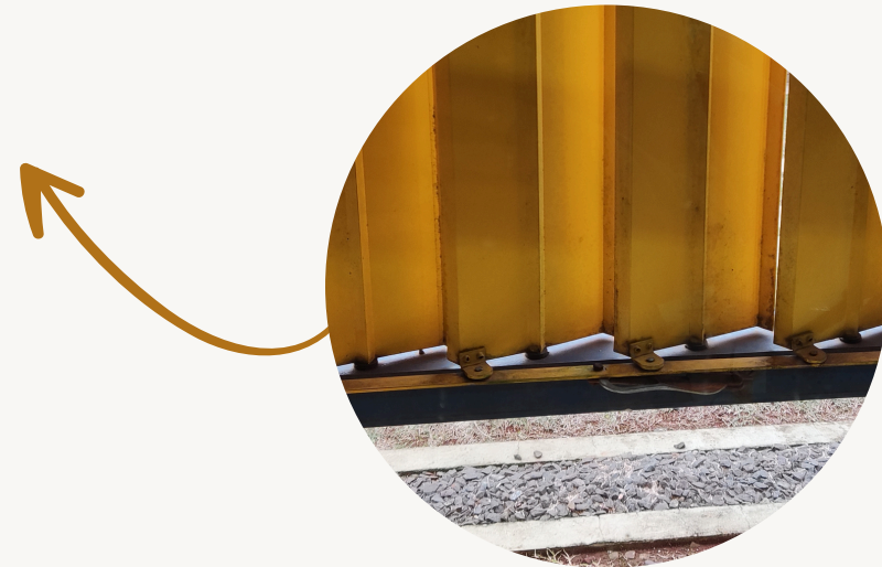
Figura 53: Detalhe do brise. Da autora (2024)
