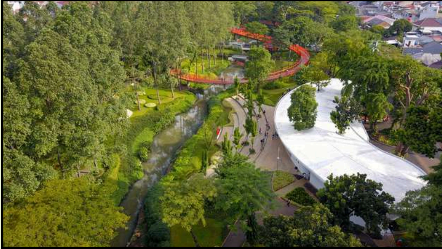
Figura 260: Relação entre elementos construídos e natureza. Fonte: https://www.siurastudio.com/tebet-eco-park
