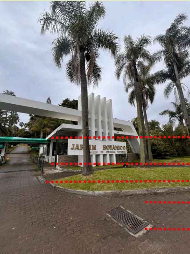
Figura 236: Acesso principal do Jardim Botânico de Porto Alegre. Fonte: Do Autor, 2024.
