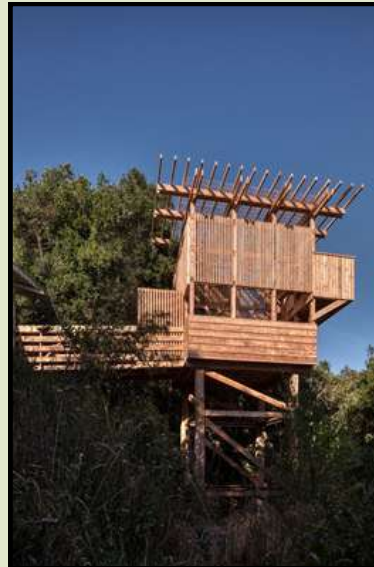
Figura 276: Torre de observação.
