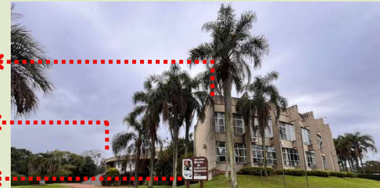
Figura 243: Edifício principal do Jardim Botânico de Porto Alegre. Fonte: Do Autor, 2024.
