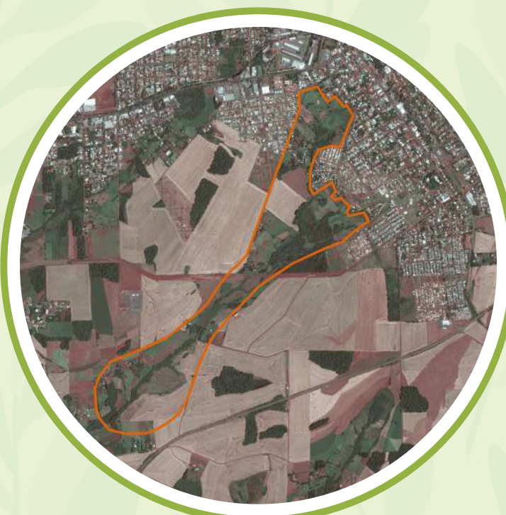
Figura 45: Situação do Sítio e entorno em 2014. Fonte: Adaptado de Google Earth, 2014.
