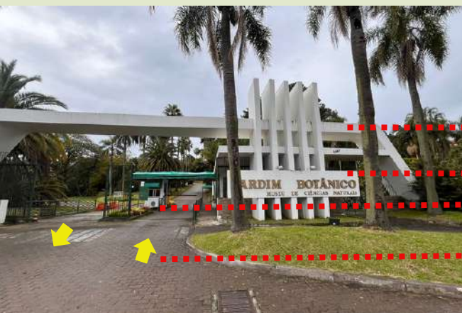
Figura 237: Acesso principal do Jardim Botânico de Porto Alegre. Fonte: Do Autor, 2024.
