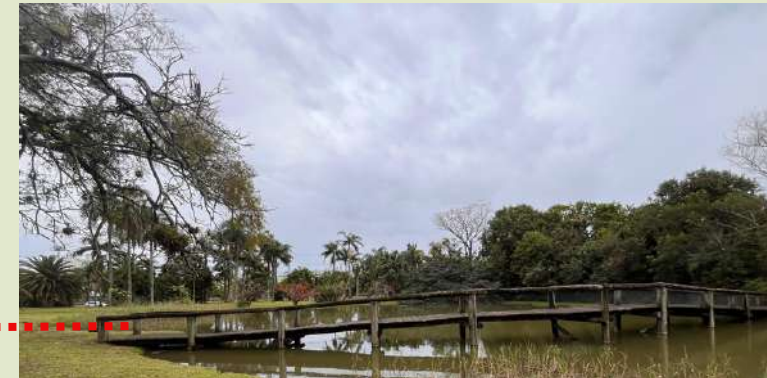
Figura 238: Ponte em madeira do Jardim Botânico de Porto Alegre. Fonte: Do Autor, 2024.
