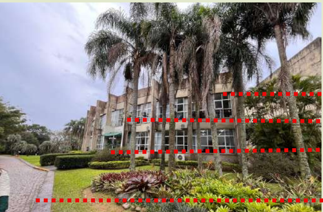
Figura 242: Edifício principal do Jardim Botânico de Porto Alegre. Fonte: Do Autor, 2024.
