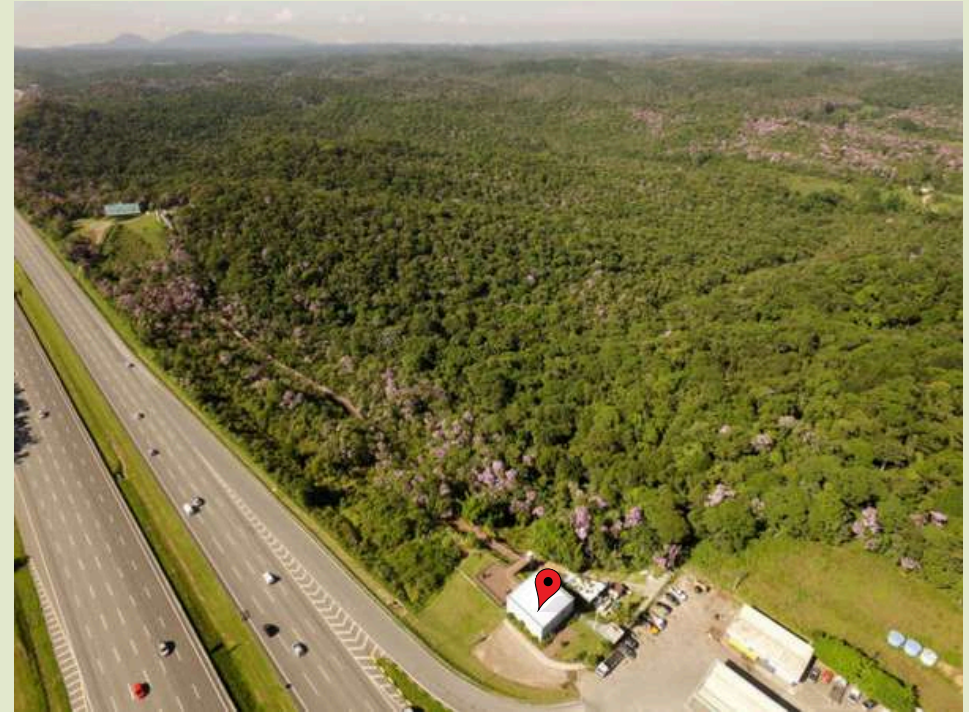
Figura 152: Vista aérea do acesso ao Parque Ecológico Imigrantes. Fonte: Adaptado de Gesto Arquitetura, 2012.
