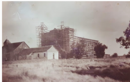
Figura 33: Construção da Igreja Matriz. Fonte: Eduardo Schneider, 2017.
