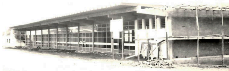
Figura 26: Rodoviária de Santa Rosa em 1957. Fonte: CHIIRSTESEN, 2022.
