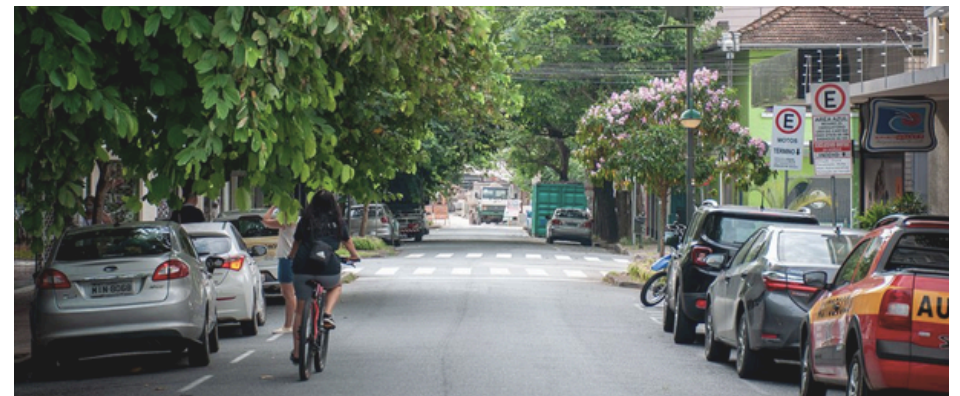
Figuras 143 e 144: Trechos da Curt Hering antes da requalificação. Fonte: Pancho, 2021.
