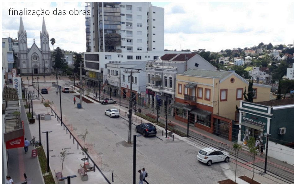
Figura 123: A Avenida durante a finalização das obras. Fonte: O Estafeta, 2022.
