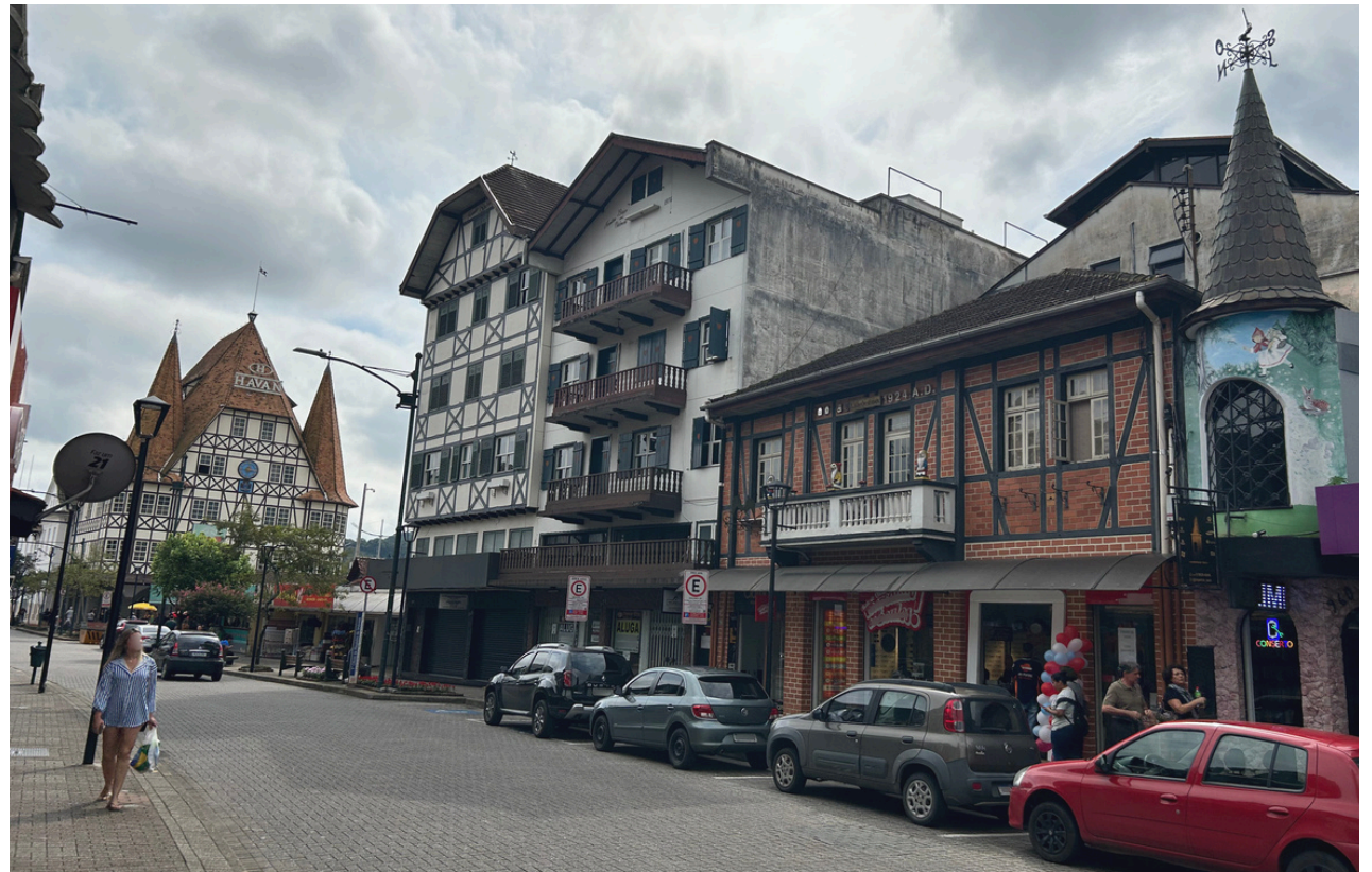
Figura 170: Rua XV de Novembro, localizada no centro da cidade de Blumenau/SC. A rua acomoda a grande maioria dos 56 pontos de contemplação existentes na Trilha do Patrimônio. Fonte: da Autora, 2024.
