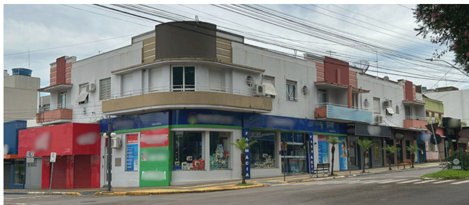
Figura 24: Edifício Lunardi, 2024. Fonte: Da Autora, 2024.
