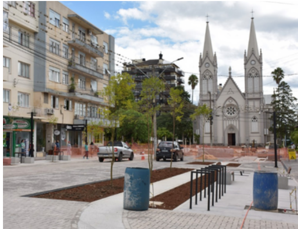
Figura 120: Conclusão das obras. Fonte: Caroline Cesca, 2022.
