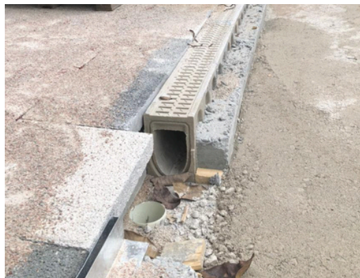
Figura 156: Instalação dos ralos e canaletas de drenagem da Curt Hering. Fonte: MANNZ, 2021.
