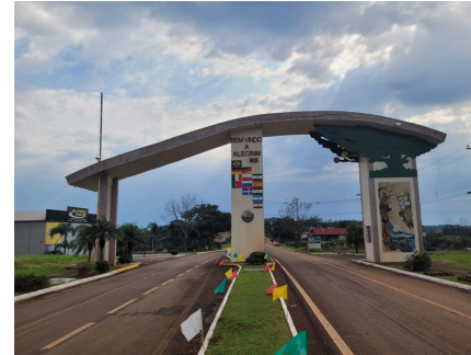
1- Pórtico de entrada da cidade
