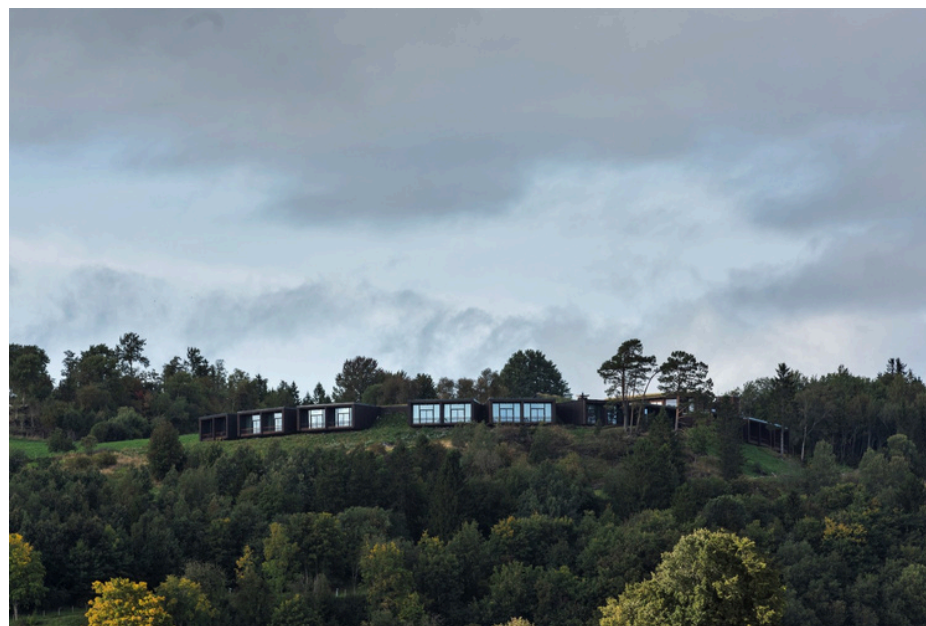
Figura 114 e 115 : Imagem aérea do hotel Fonte: Archdaily, 2024.
