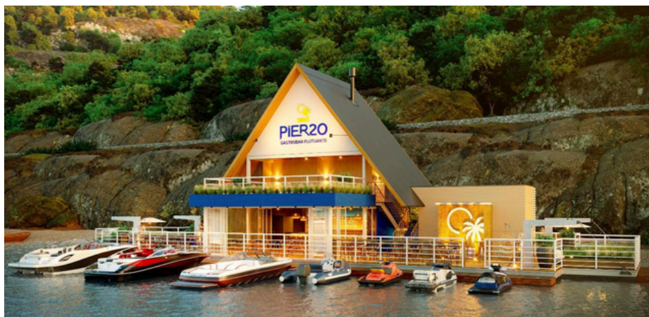
Figura 15: Matéria sobre a construção de um restaurante flutuante em Porto Mauá Fonte: Prefeitura de Porto Mauá , 2023.
