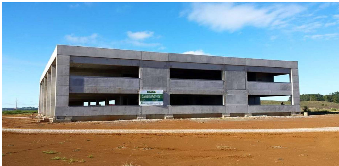
Fotografia 7 – Segunda fase da construção do então Bloco Administrativo
