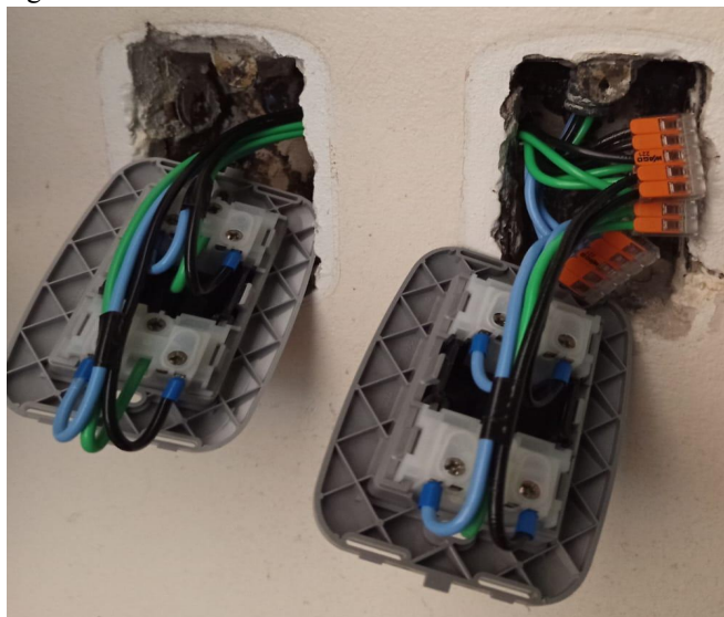
Fig. 11. Tomadas de uso geral após Retrofit
