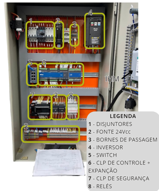
Figura 19 - Montagem do painel elétrico de comando
